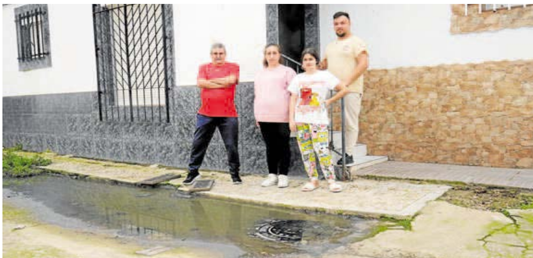
Soledad Jiménez junto a sus vecinos en la puerta de su casa, donde no deja de salir agua sucia del colector. CASIMIRO MORENO
