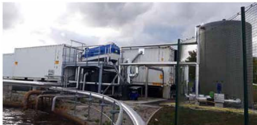
Unité REUT d'eau de station d'épuration en appoint des TAR, conçue et fabriquée par Aquaprox I-Tech pour une IAA française.
