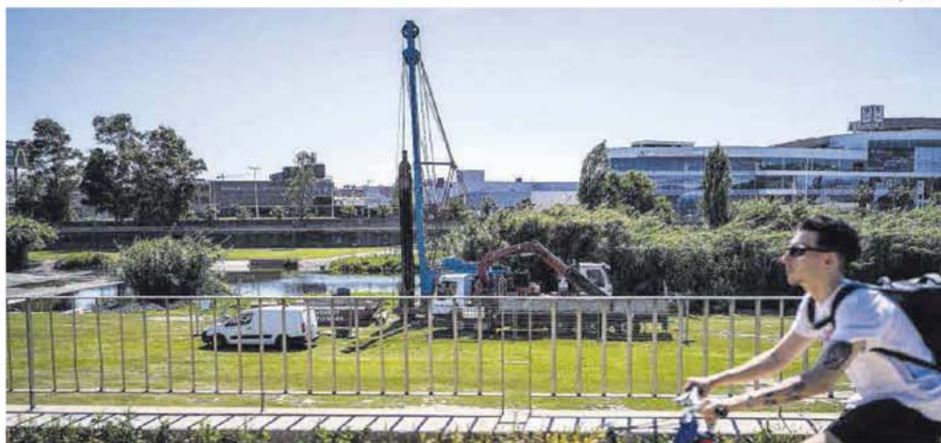
Obras de construcción de pozos en el río Besòs, el pasado junio.
