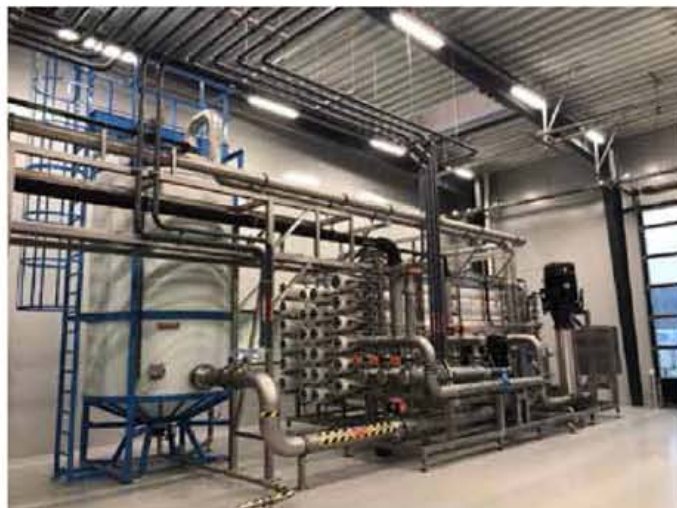
Figure 1 - Photo d'une installation dans une brasserie pour réutiliser jusqu'à 80% des eaux usées - Technologie principale : CCRO – Printemps 2021, au Danemark
